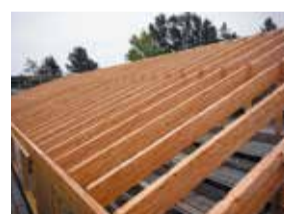
傾斜屋根を支える集成材の梁。
