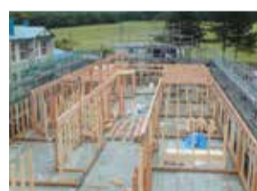
建設現場に搬入された構造用森林認証材の組み立て。
