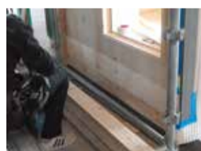
森林認証材トドマツを加工した羽目板の貼り付け作業。
